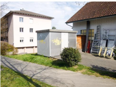
Dank der strahlungsarmen Ausführung des neuen Transformators können die NISV-Vorschriften besser eingehalten werden. Auch die Sekundärkabel werden NISV-optimiert ausgeführt. Die MS-Anlage und NS-Verteilung haben die Lebensdauer erreicht und werden durch neue Anlagen ersetzt. Somit soll das komplette Innenleben der Trafostation «Gass» wieder auf dem neuesten Stand der Technik sein. Leider wurde mit Beginn des Krieges in
